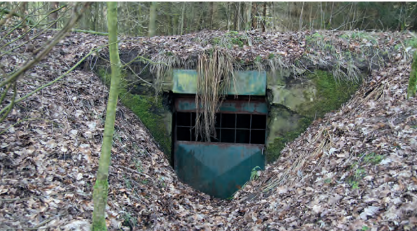
Resterbunker als Quartier für Fledermäuse auf der DBU-Naturerbefläche Dammer Berge
