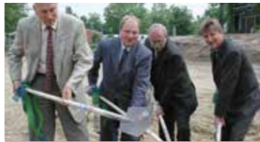
2001 Spatenstich 2: Zum Zehnjährigen startet die DBU mit dem Bau des neuen Konferenz- und Ausstellungsgebäudes.
