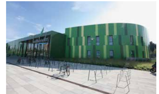
Seiner Zeit voraus: In Bamberg wurde das erste Passivhaus-Schwimmbad Europas gebaut, das Bambados.
