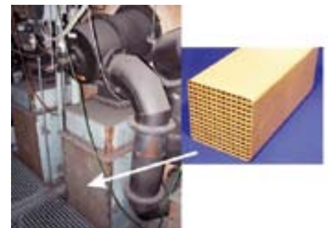
Die wabenförmigen Wärmetauscher bestehen aus Keramik.
