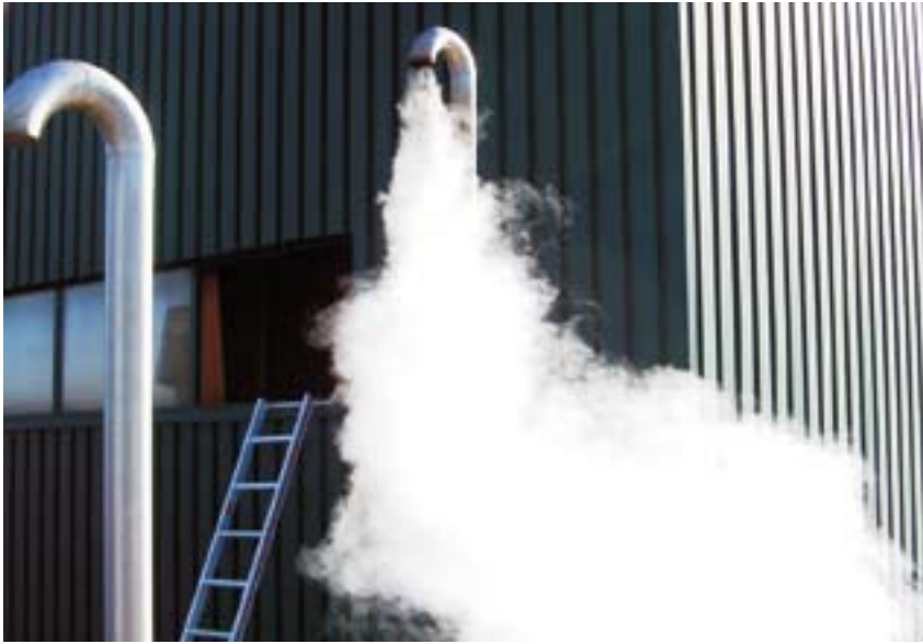
Wasser in Wärmeversorgungsanlagen muss regelmäßig entgast werden – das ausgekochte Gas-/Dampfgemisch wird als »Fegedampf« abgegeben.
